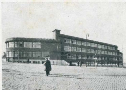
Bâtiment d'Administration de la S.N.C.F.B. à Charleroi (vue vers la Ville). Chauffé par la vapeur sous vide partiel.
